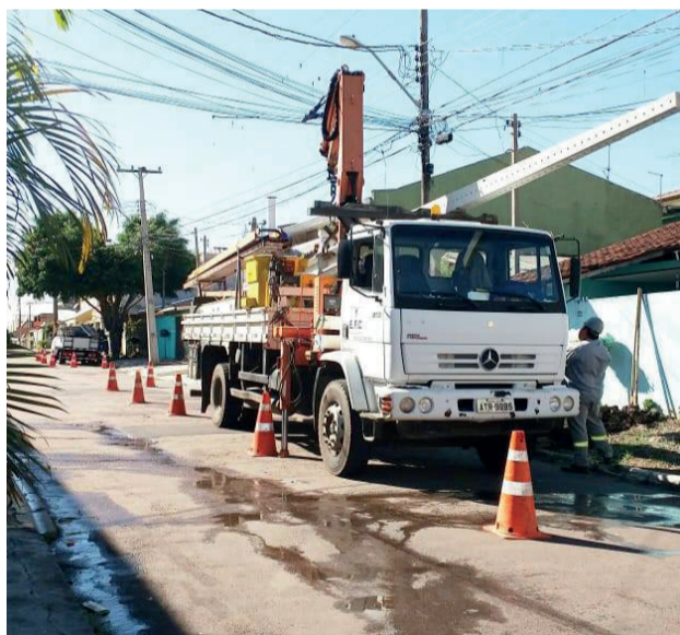
Reparos na iluminação pública em diversas ruas de Curitiba.
