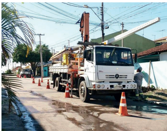
Reparos na iluminação pública em diversas ruas de Curitiba.
