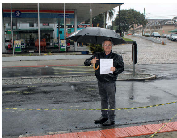
Obras na Rua João Bettega, no bairro Portão.
