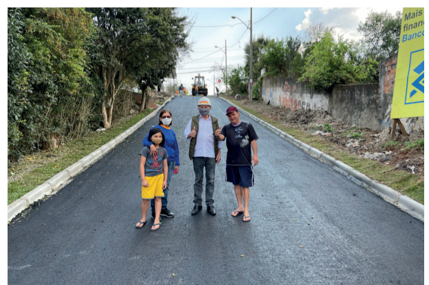
Asfalto na Rua João Maria José de Farias, no Xaxim.
